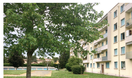
Résidence collective, rue des Molières.
