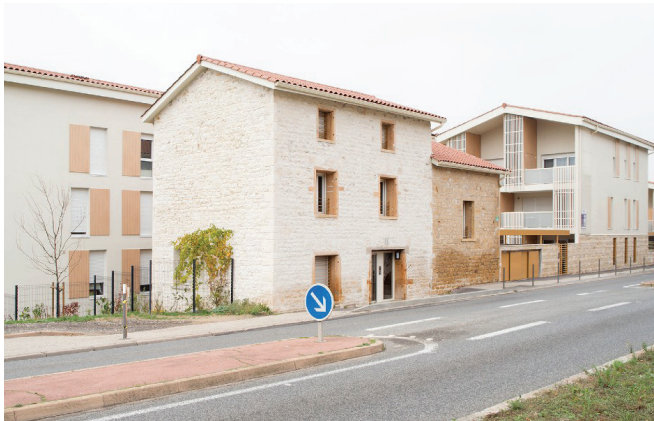
▲ Réhabilitation d'habitat rural et construction de logement collectif, Lissieu (69), Silvère Weiss Séméio Architecture.
