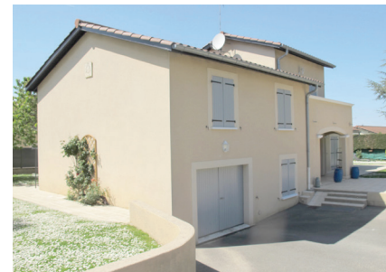
Maison individuelle, caractéristique de ce type de tissu : bâtie en R+1 implantée isolée dans la parcelle, avec garage en RDC, etc.
