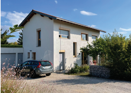
▲ Maison basse énergie, Lucenay (69), Fabien Perret Architecture.
