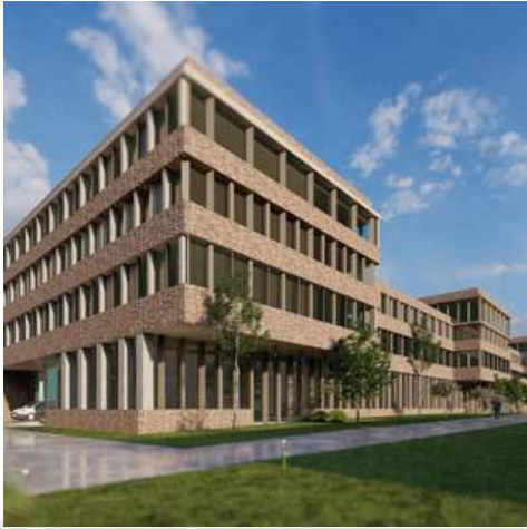
IMMEUBLE DE BUREAUX SAINT GENIS LAVAL
